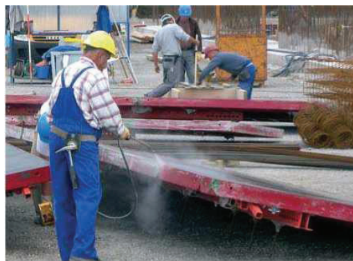
Εικόνα 2 - Εφαρμογή αντικολλητικού με ψεκασμό
