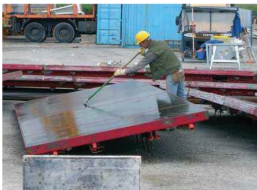
Εικόνα 1 - Ομοιόμορφη εφαρμογή αντικολλητικού με λαστιχένια σπάτουλα
