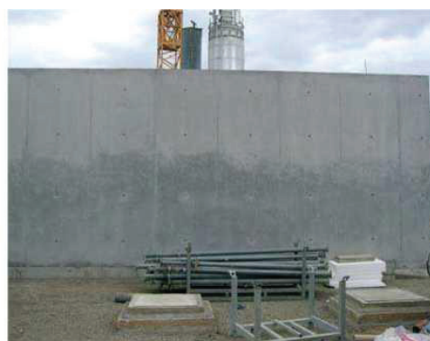
Εικόνα 8 - Εμφανής διαφορά απόχρωσης (μη αποδεκτή)
