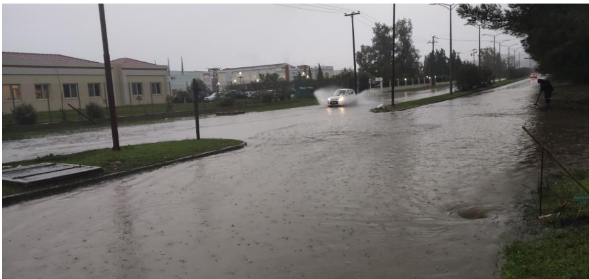
Εικόνα 2 Άποψη της περιοχής μελέτης του βόρειου τμήματος του Ε.Π. Πάτρας κατά την εμφάνιση πλημμυρικών φαινομένων.
