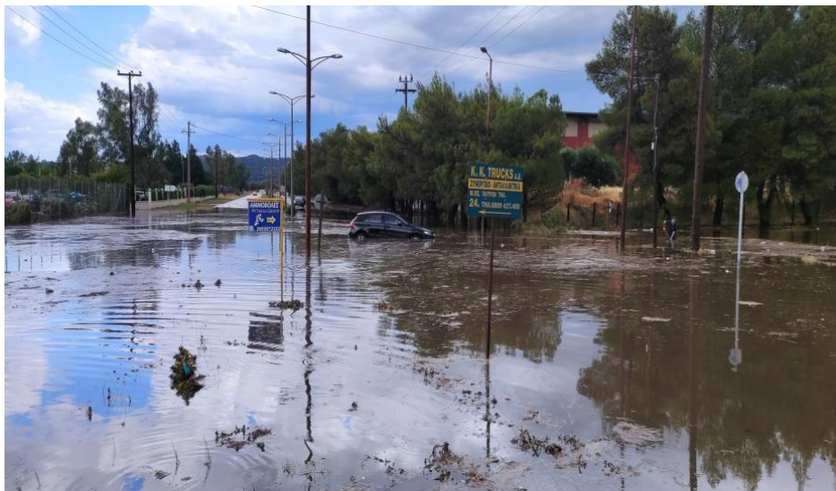
Εικόνα 1 Άποψη της περιοχής μελέτης του βόρειου τμήματος του Ε.Π. Πάτρας κατά την εμφάνιση πλημμυρικών φαινομένων.
